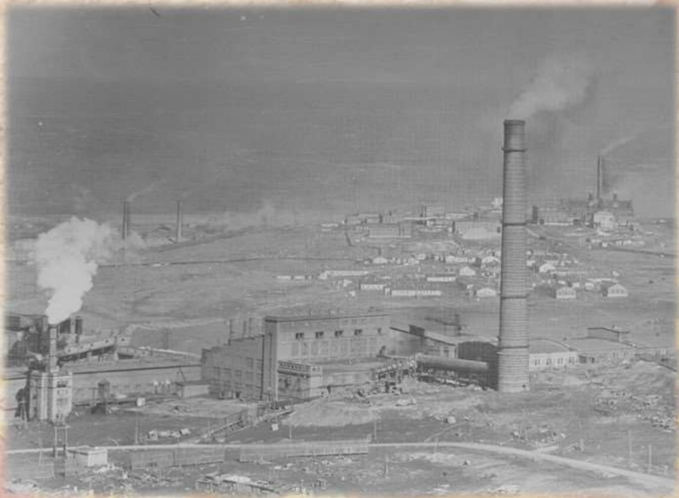
Поселок Норильск со стороны Никелевого завода. 1940-е НГА Ф.Р-11.Оп.1.Д.2361-2
