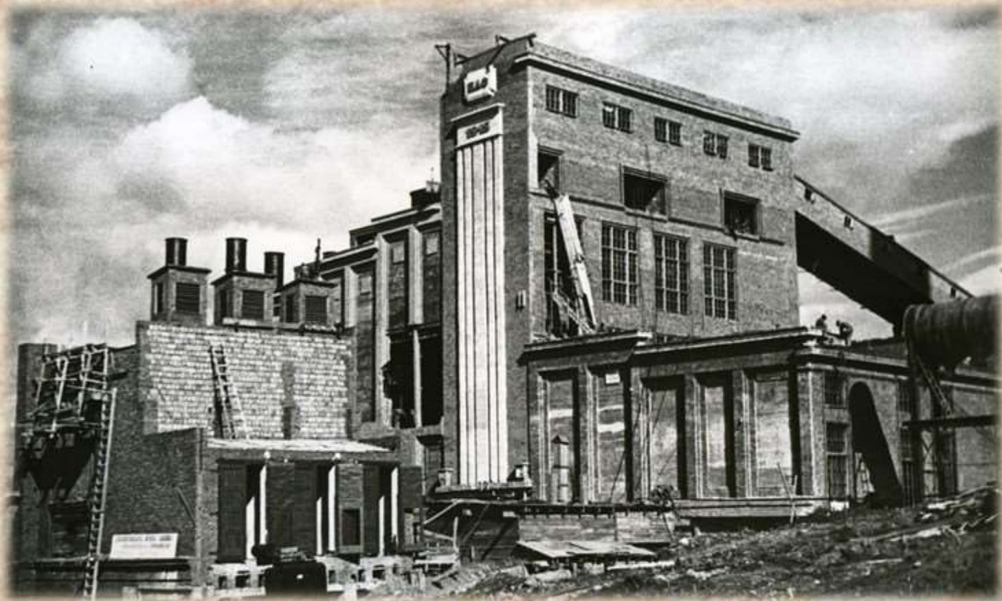
Строительство большой аглофабрики. 1945 г. НГА Ф.Р-75.Оп.1.Д.1763
