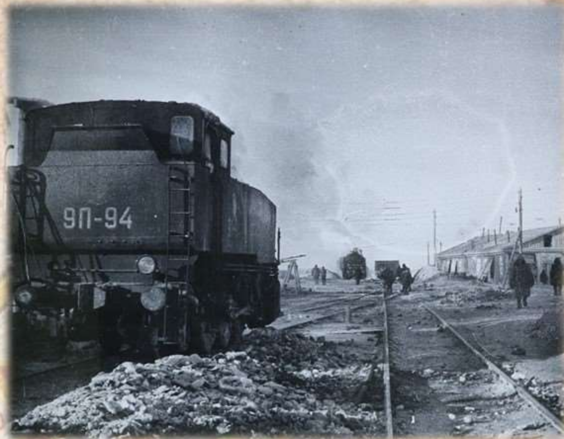
Площадка строительства ТЭЦ-1 НГА Ф.Р-75.Оп.1.Д.2526
