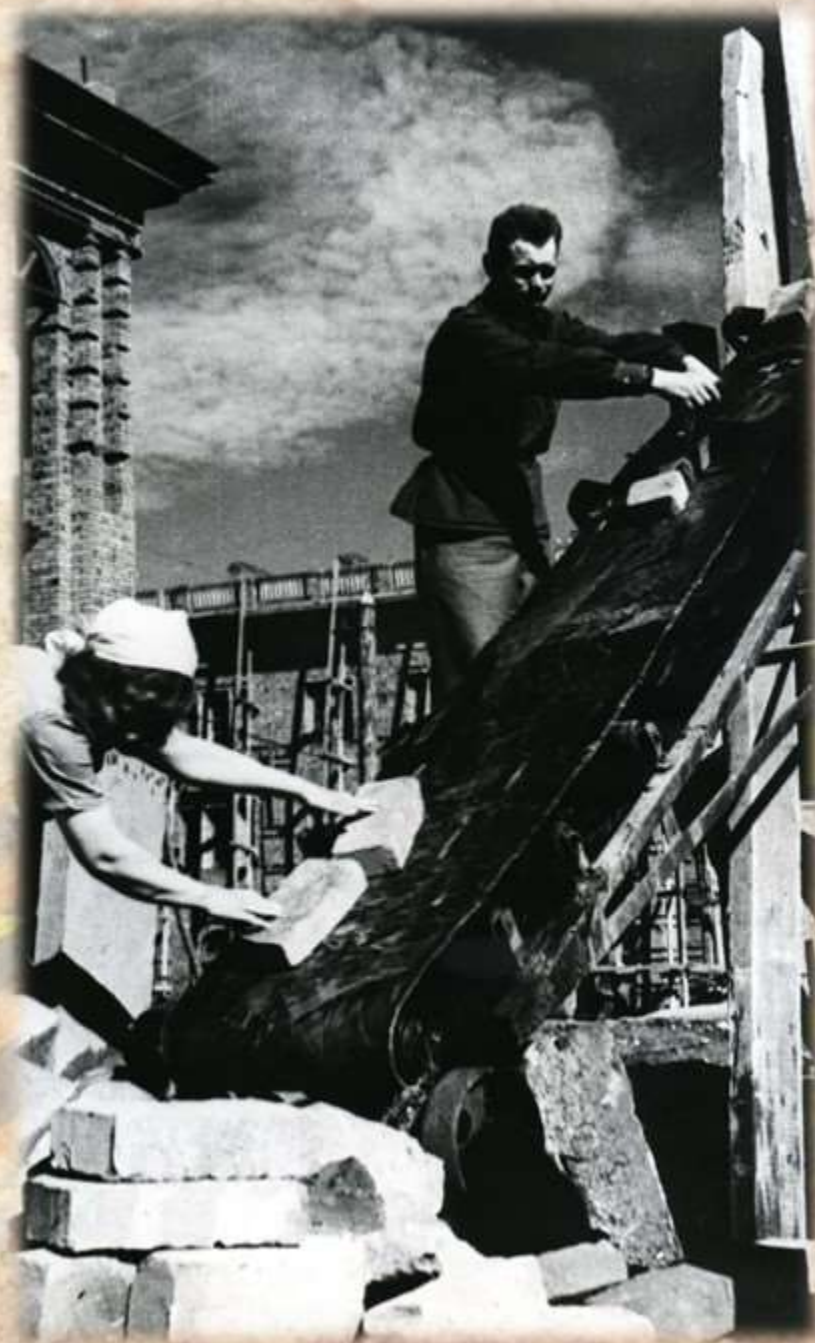
Механизация строительства на улице Севастопольской. 1945 г. НГА Ф.Р-75.Оп.1.Д.1827
