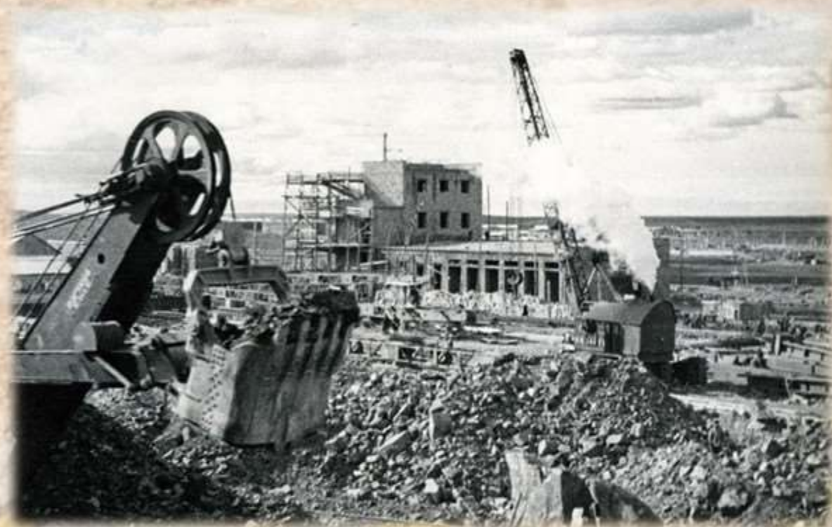
Строительство ТЭЦ-1. 1941 г. НГА Ф.Р-75.Оп.1.Д.1949
