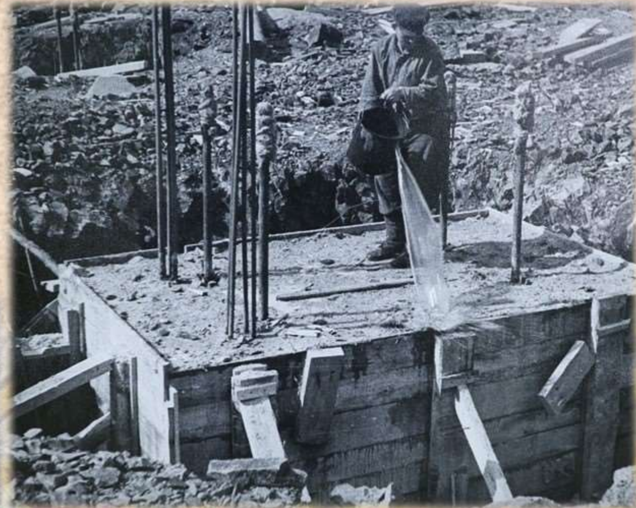
Рабочий на строительстве ТЭЦ-1 НГА Ф.Р-75.Оп.1.Д.2527
