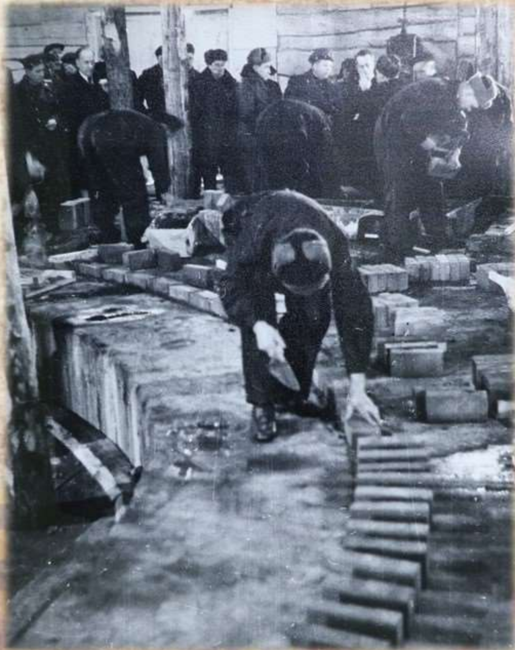
Строительство ТЭЦ-1. Укладка кирпича. НГА Ф.Р-75.Оп.1.Д.2533
