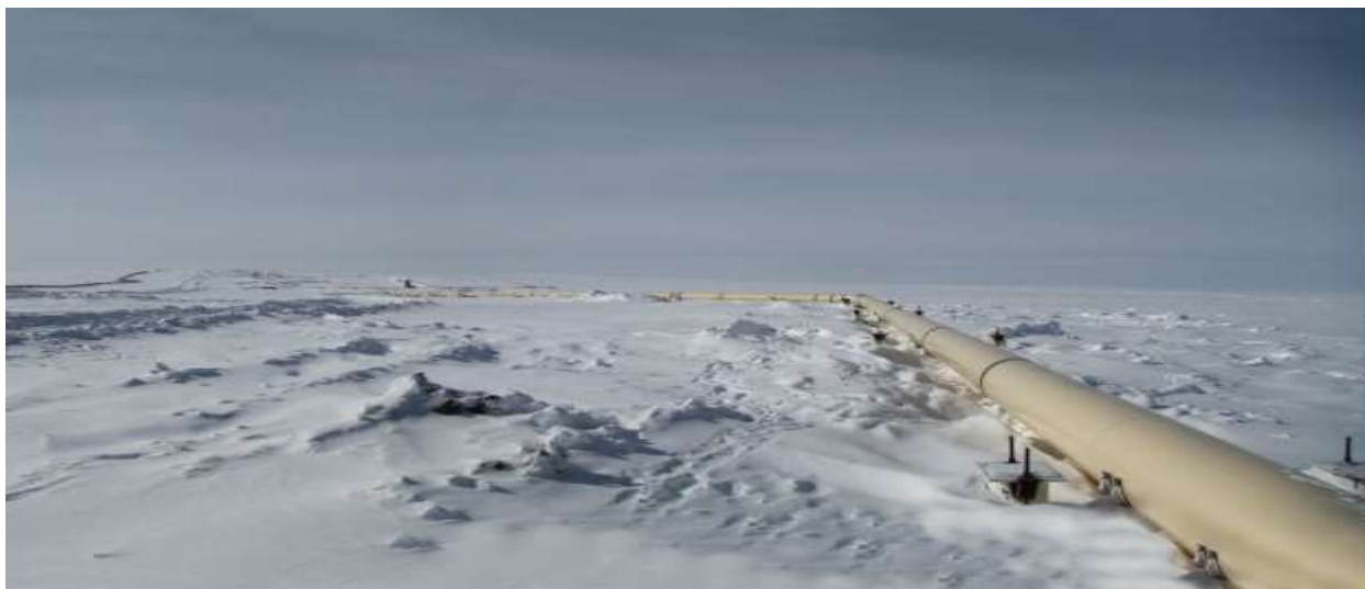
Рисунок 19 - Межпромысловый газопровод «Пелятка – Северо-Соленинское»
